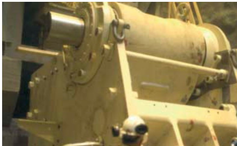
Ein Nordberg C200 bei der Installation in einem Bergwerk. Der Brecher wurde in Einzelteilen unter Tage transportiert und dort zusammengesetzt.
