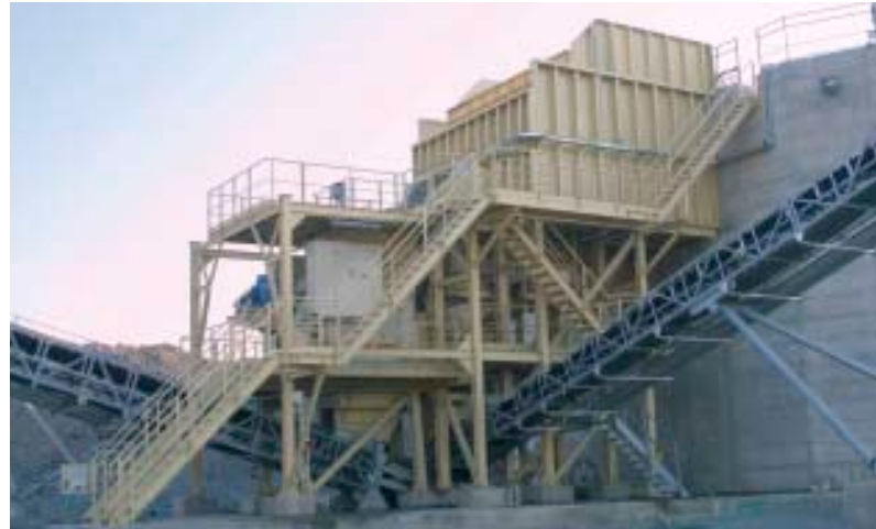
Montage einer neuen Vorbrechanlage mit C125.
