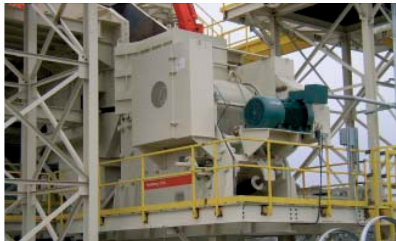
Montage einer neuen Vorbrechanlage mit C145.
