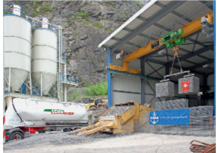
Rund 15% des von der SBB benötigten Bedarfs an Bahnschotter wird mit Zingel-Gestein abgedeckt. Der Steinbruch liefert rund 65'000 t Bahnschotter und etwa 15'000 t hochwertiges Fundationsmaterial an die Bahn
