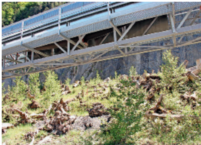
Der Steinbruch Zingel ist dank umfangreicher Rekultivierung auch ein Naturpark. Er bietet Lebensraum für eine reichhaltige Tier- und Pflanzenwelt, zu der bisher rund 130 Pflanzenarten dokumentiert werden konnten
